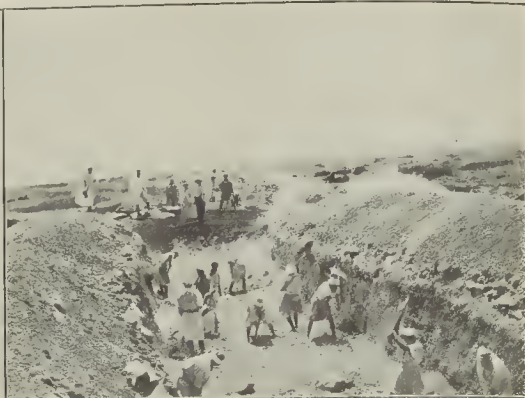
Moros adictos construyendo el canal de la Restinga
